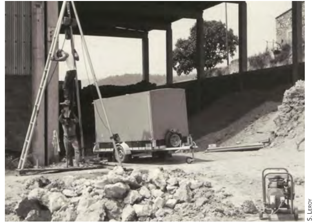
Figura 291. Maniobra de muestreo del testigo BO-II en 1983 sobre el suelo de la cantera de Bòbila Ordis
