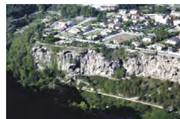
Figura 299. Vista de la Cinglera del Capelló
