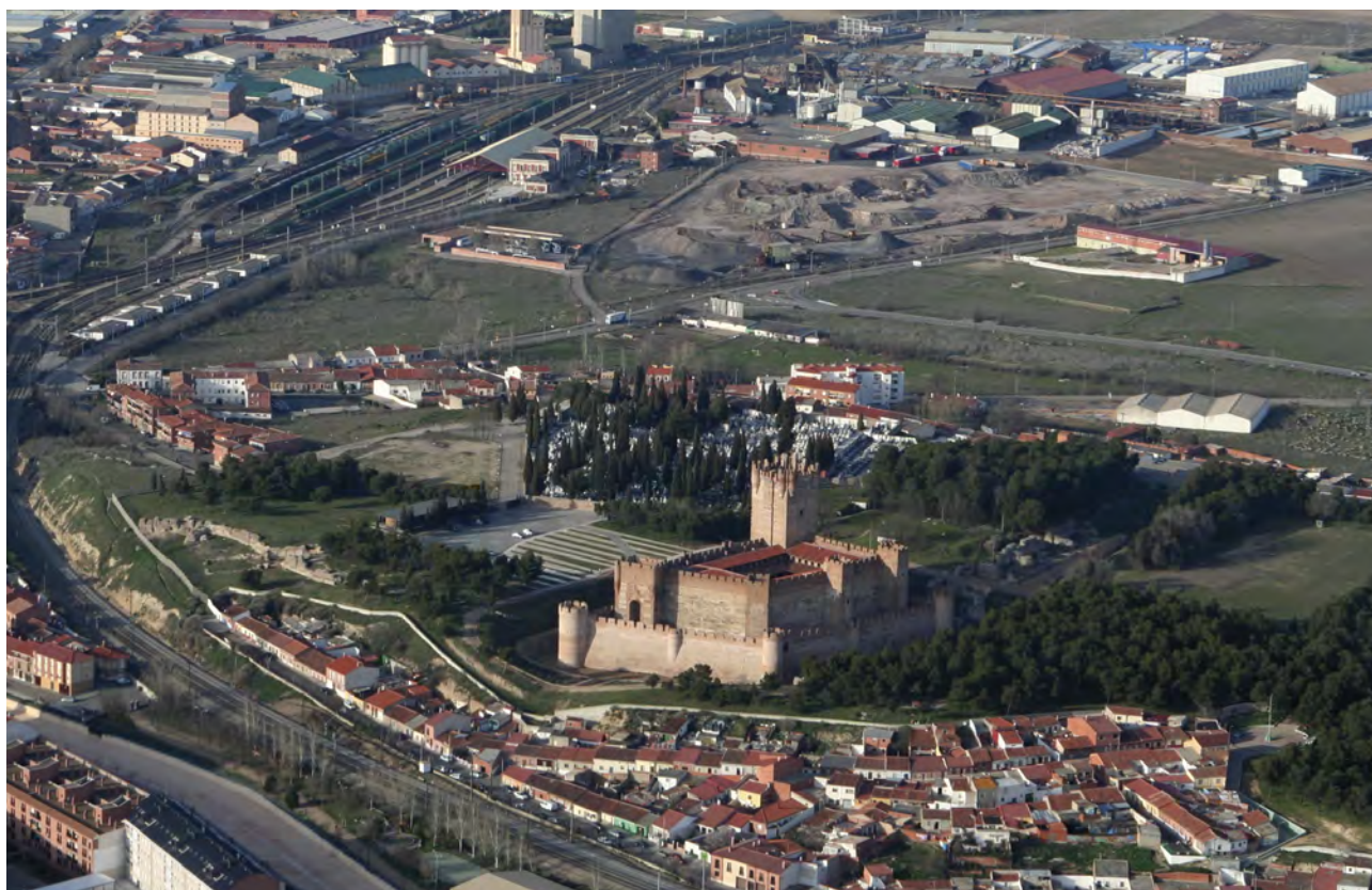
Figura 508. Vista aérea del castillo de La Mota en Medina del Campo, Valladolid
