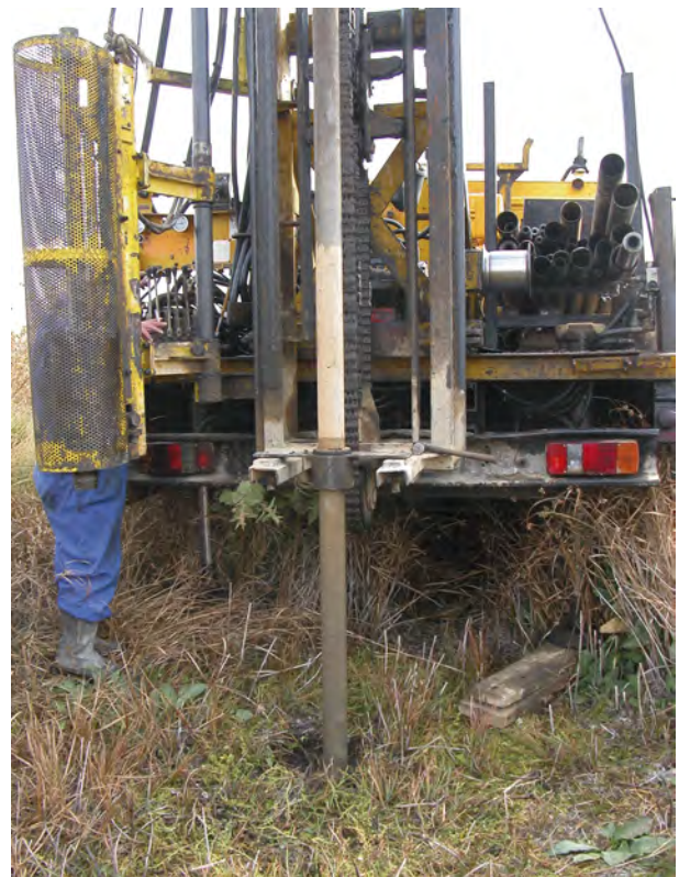
Figura 510. Sondeo del bodón de Almenara de Adaja
