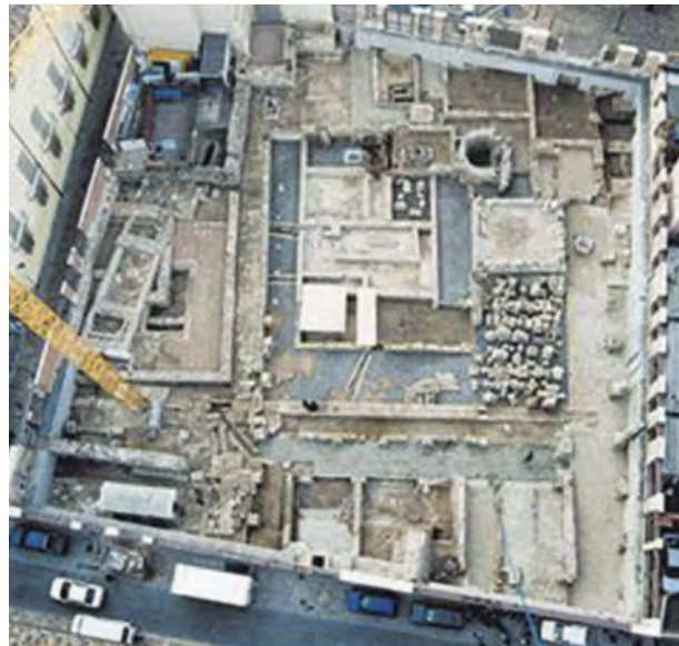
Figura 726. Excavaciones en Almoína (Valencia), año 2003
