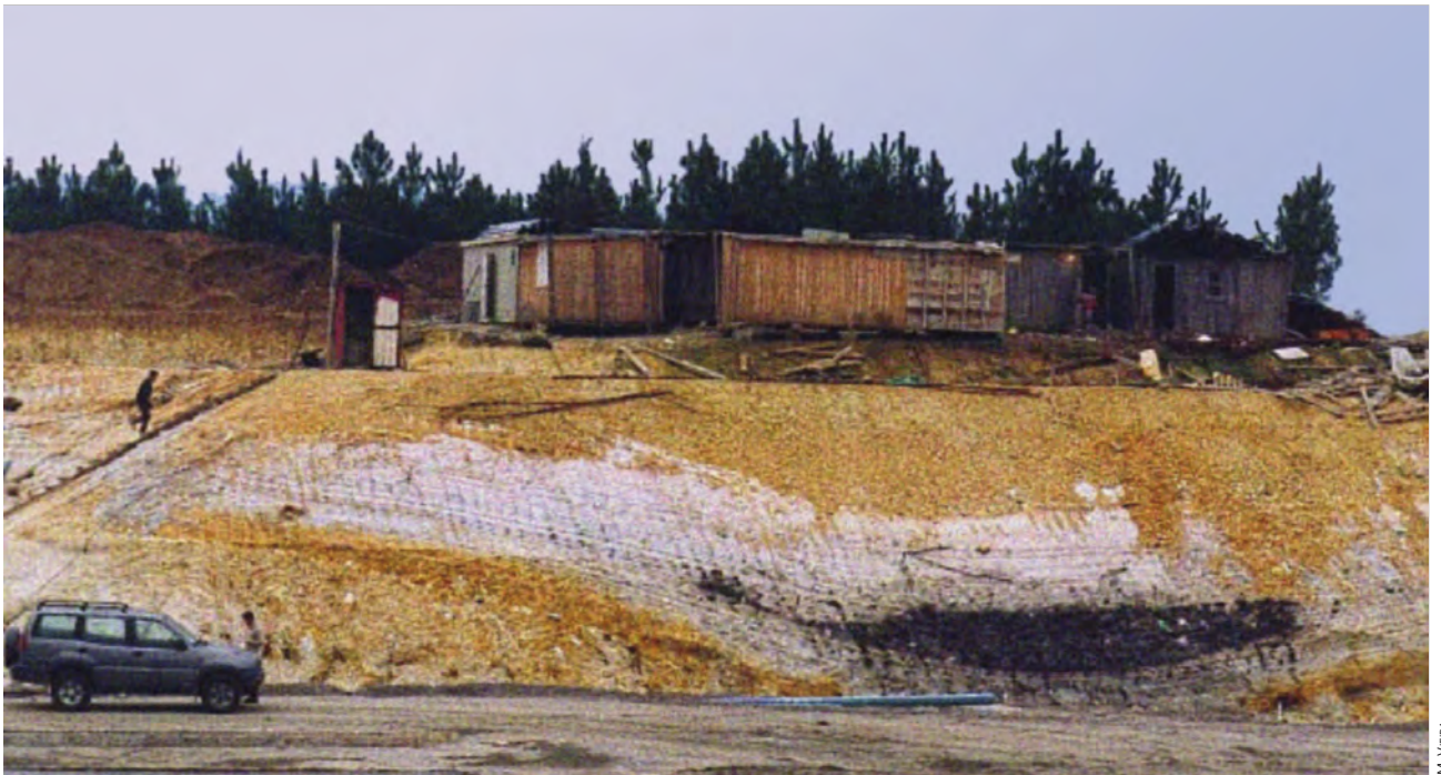
Figura 759. Nivel de arcillas negras pliocenas descubiertas en el talud de la autopista portuguesa A3 a la altura de São Pedro da Torre
