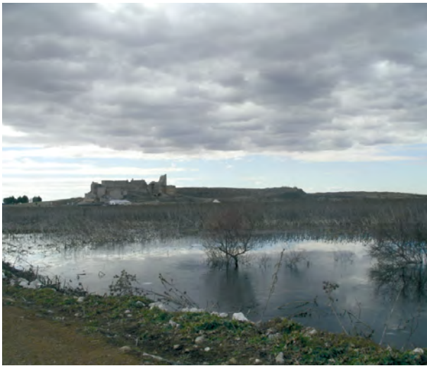
Figura 619. Castillo de Calatrava y zona higróturbosa inundada, imagen de 2005
